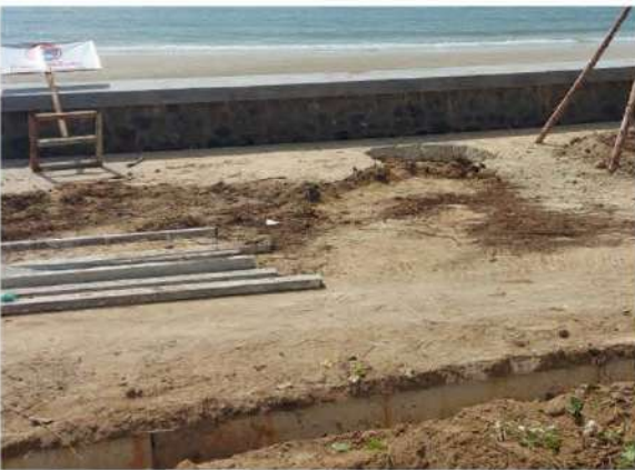
รูปที่ 2-33 การขุดลอกทำความสะอาดแนวรางระบายน้ำ
