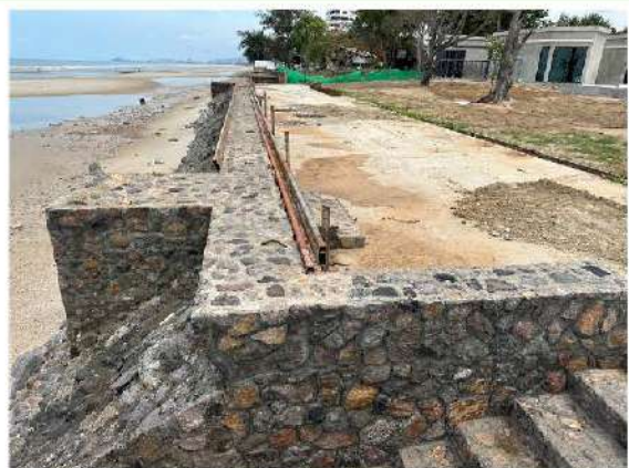
รูปที่ 2-49 หินยาแนวตลอดแนวเชื่อมกันดิน
