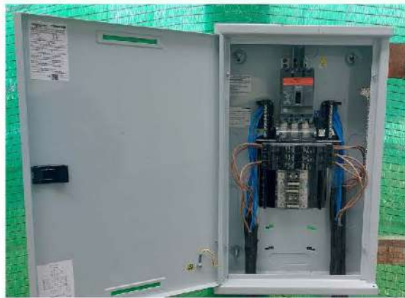
รูปที่ 2-46 แผงควบคุมและสวิตช์ตัววงจรไฟฟ้า
