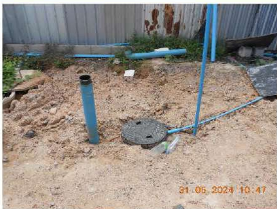
รูปที่ 2-31 ระบบบำบัดน้ำเสียสำเร็จรูป
