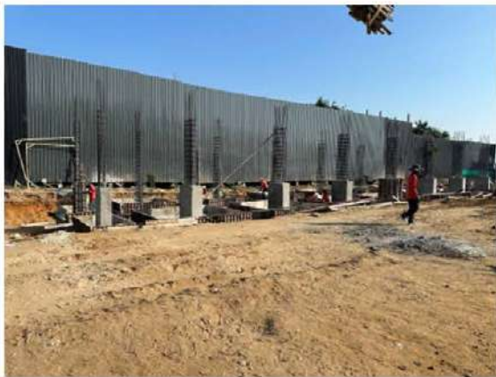
รูปที่ 2-26 ผนังกันเสียง (Steel) หนา 1.27 มม. (หรือวัสดุเทียบเท่า) สูง 6.00 ม. ที่ชั้น 1
