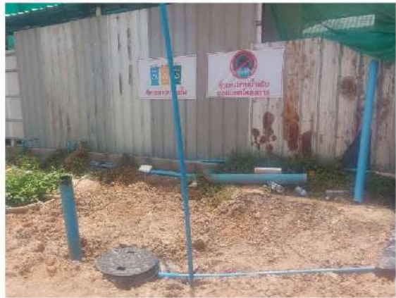
รูปที่ 2-30 ท่อรวบรวมน้ำเสียจากห้องส้วมสู่ระบบบำบัดน้ำเสียของโครงการ
