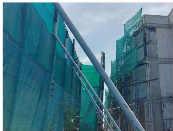
รูปที่ 2-19 ตาข่ายกันฝุ่นคลุมรอบอาคาร
